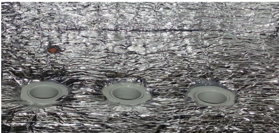
фото 8 — Расположение сальников для подключения питания терминала
